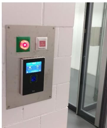
Danach Personendurchtritt durch Vereinzelung und Entnahme des Material von innen (Fingerprint Terminal und danach Taster „Türe schliessen“ betätigen).
