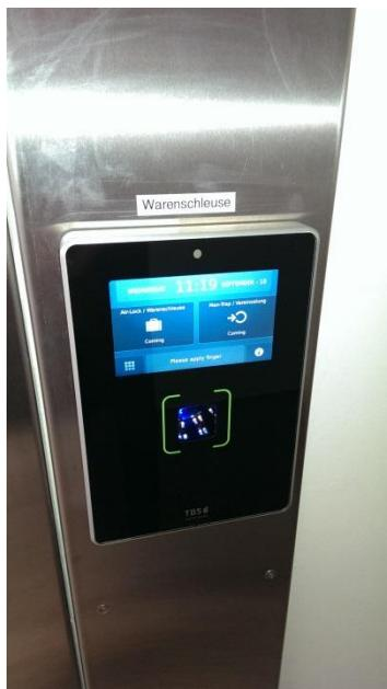
WarenSchleuse mittels Autorisierung am Fingerprint Terminal öffnen. Die Aussentüre ganz aufziehen, bis sie von selbst hält.
