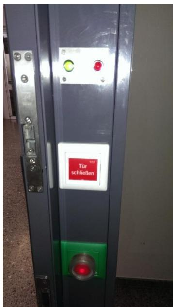
Danach Personendurchtritt durch Vereinzelung und Entnahme des Material von innen (Fingerprint Terminal und danach Taster „Tür schliessen“ betätigen).
